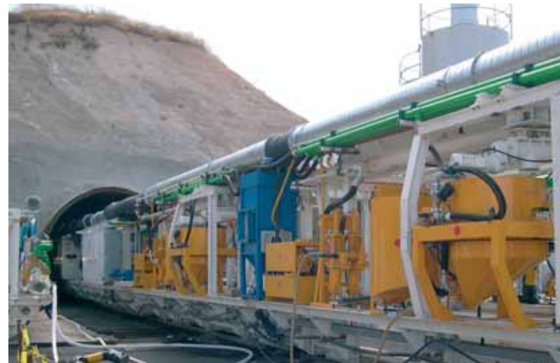
Injektionssysteme im Einsatz, Kalifornien
