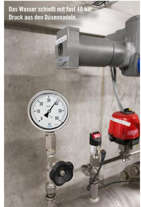
Das Wasser schießt mit fast 40 bar Druck aus den Düsenadeln.
