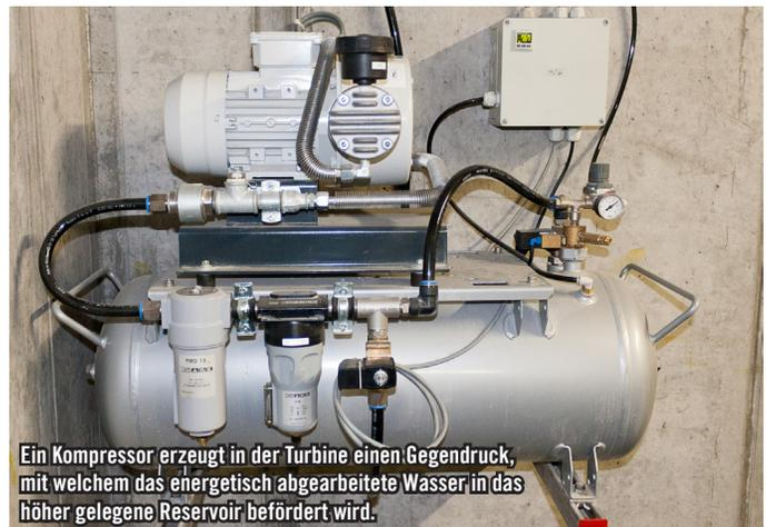
Ein Kompressor erzeugt in der Turbine einen Gegendruck, mit welchem das energetisch abgearbeitete Wasser in das höher gelegene Reservoir befördert wird.
