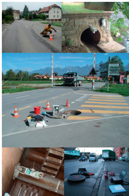
Mit dem neuesten Durchflussmesssystem werden Strömungsgeschwindigkeit und Niveau berührungslos gemessen.
